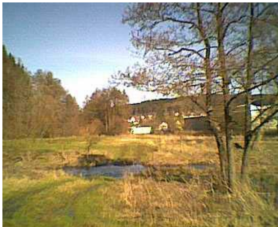
Bild 18: Kurz vor Sundern, im Hintergrund: Stemel / Fa. Schmacke: Die Röhre zerschneidet den Weg durch die Wiesen
