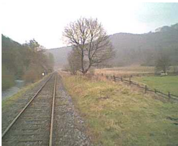
Bild 7: Blick von Reigern Richtung Müschede: entlang der Bahn ist ausreichend Platz
