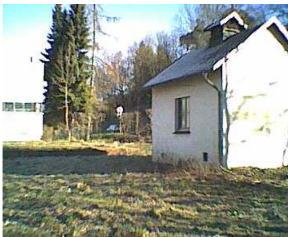
Bild 11: ...die gleiche Stelle aus der entgegengesetzten Richtung (links: Fa. Froh).
