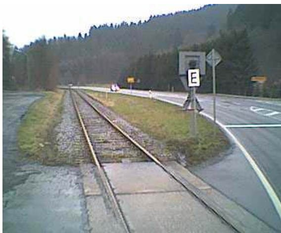
Bild 9: Ortseingang Hachen / Bahnübergang: Vor dem Bahnübergang mündet der Streckenabschnitt Müschede – Hachen auf die Straße und folgt dann in der Ortsdurchfahrt Hachen der B 229
